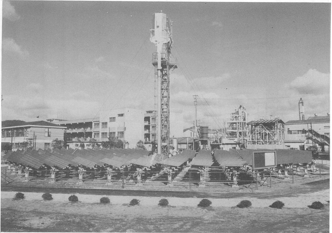
図5 タワー集光方式による太陽熱発電プラント 三菱重工広島造船所で建設された150kWプラントで平面鏡群よりの反射光は中央の塔上のボイラに集光される。
