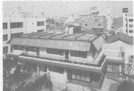
(c) アモルファスシリコン太陽電池ソーラハウス (三洋電機提供)
