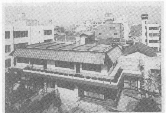
写3 a-Si 太陽電池パネルを設置した実用化モデル住宅（大阪府守口市、出力2 kW）
