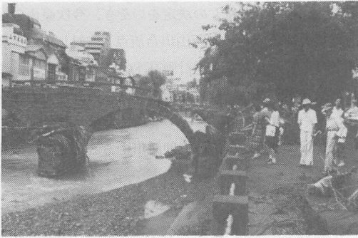
写1 大破した中島川の「眼鏡橋」(重要文化財) 1982. 7. 25写
