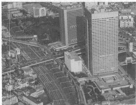
図-1 コミュニティエネルギーシステム (CES) を採用した芝浦地域冷暖房
