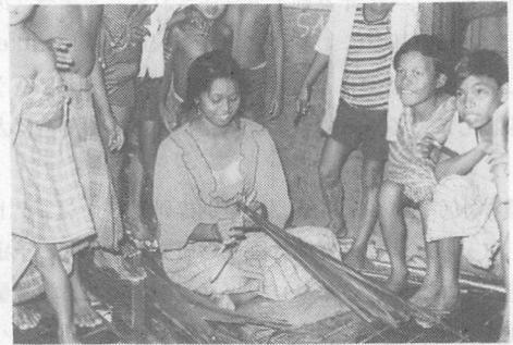
図-4 サゴヤシの葉を用いて屋根ふき材(アタップ)を製造する。
