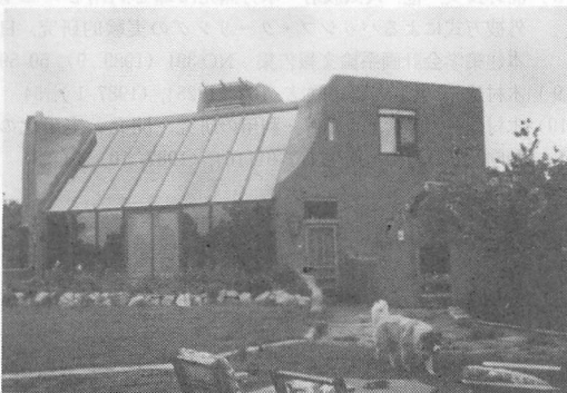
写-6 米国サンタフェのバルコム邸。吹抜温室のある典型的なパッシブソーラーハウス (S. ニコルズ設計)
