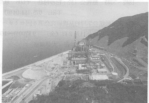
写1 「もんじゅ」全景（南から）
