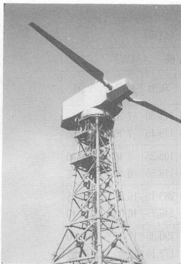
図-1 NEDO100kW機(三宅島)
