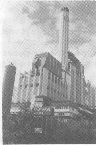
写3 ベステロース熱併給発電所
