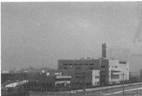
図-2 東部スラッジセンター
