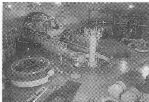
写4 燃料取扱設備試験中の原子炉格納容器
