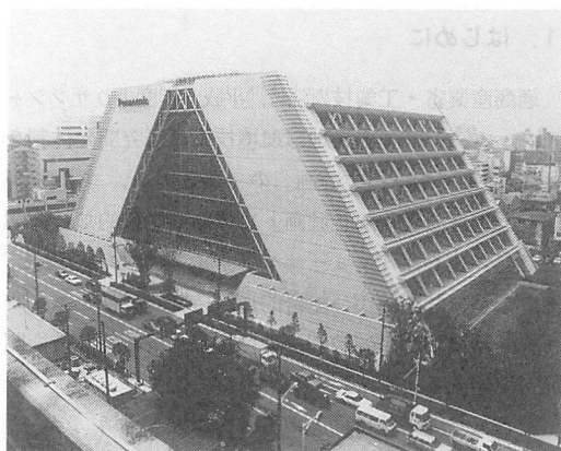
情報通信システムセンター（東京・東品川）
