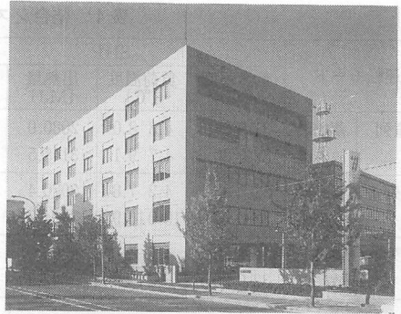
写真5 総合研究所新館建物外観
