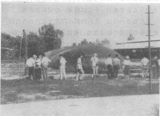
図-3 タイにおける豚舎からの排泄物によるメタンガス発生タンク
