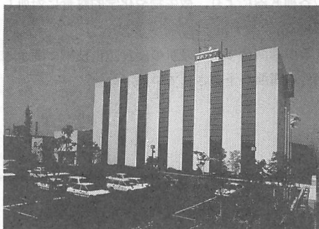
総合技術センター外観
