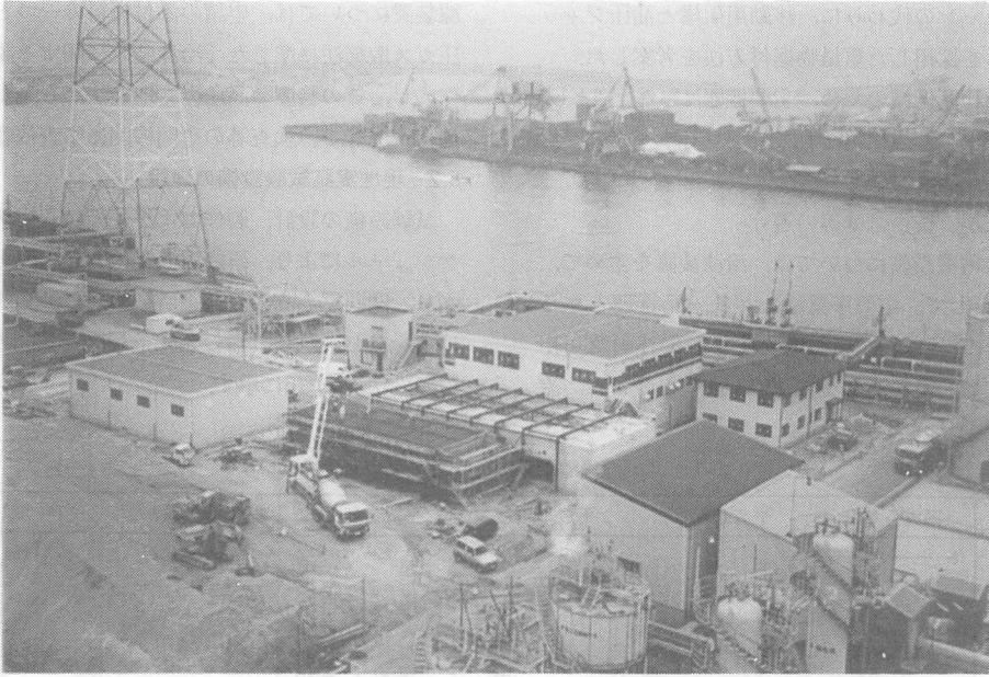
写6 現地実証試験設備建設工事状況
