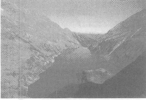
写真4 カプルン揚水発電所の下部貯水池
