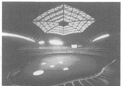
写2 屋根透光部による自然採光 (ナゴヤドーム)
