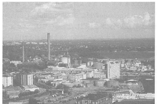
写真3 ストックホルム市のPFBC熱電併給プラント(カクネス塔より望む)
