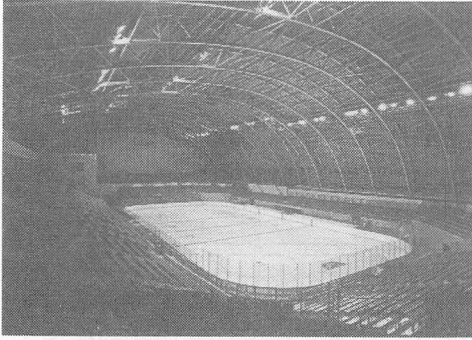
写2 内観（アリーナ南西より）
