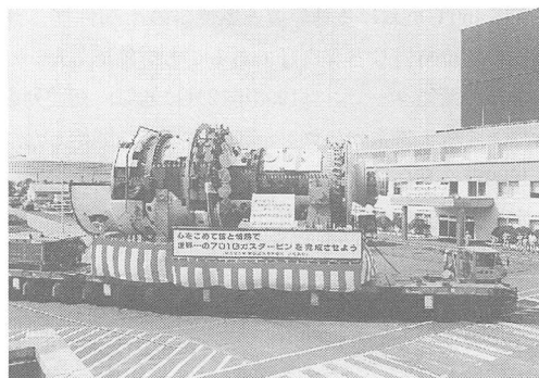
写真2 ガスタービン搬入状況
